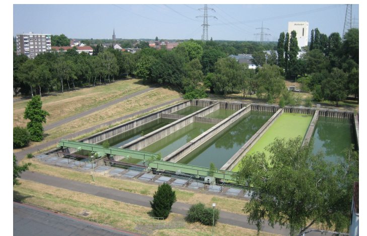
Blick vom Faulturm auf die Klärbecken
