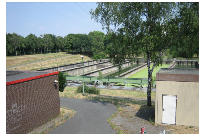
Blick vom Faulturm auf die Klärbecken
